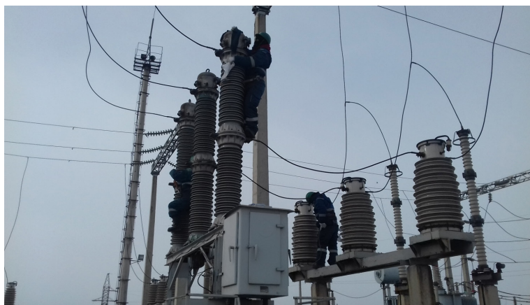
Тоноглолын хөндийрүүлгийн бохирдолт цэвэрлэх ажил хийж байгаа нь
