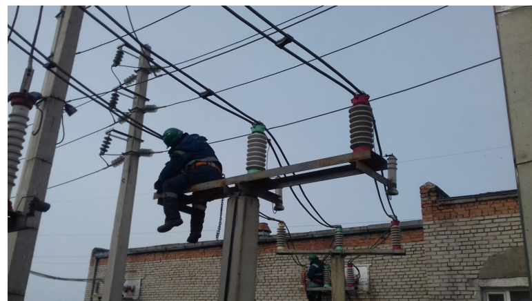
Тоноглолын хөндийрүүлгийн бохирдолт цэвэрлэх ажил хийж байгаа нь
