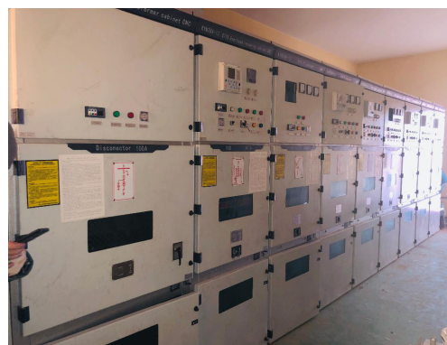
Ширээт дэд станцад суурилуулсан KYN28A-12 10 кВ-ын ячейк Cnc electric group CO.,LTD
