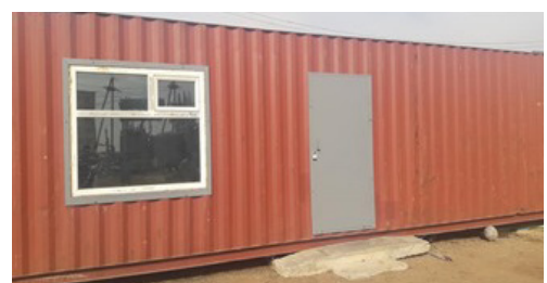
Өндөрхаан дэд станцын хамт олон контейнерт цонх, хаалга хийж тохижуулав
