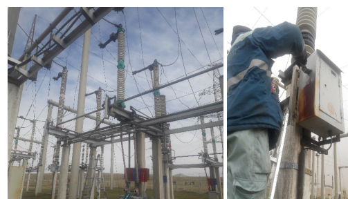
220/110/35 кВ-ын Дархан дэд станцын урсгал засварын ажил
