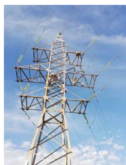
Хөтөл А,Б АШ-ын тулгуур будах ажил
