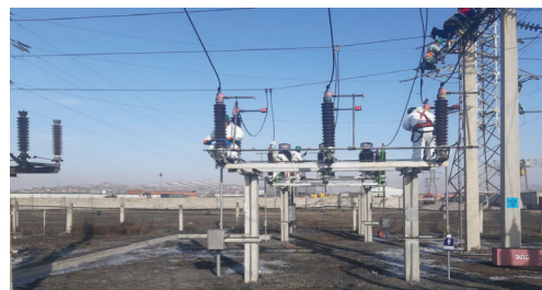
110/10 кВ-ын ПРП-110 дэд станцын 110 кВ-ын порталын хөндийрүүлэгчийн бохирдолт цэвэрлэж байгаа нь
