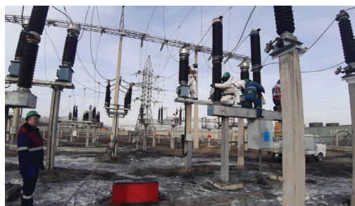
110/10 кВ-ын ПРП-110 дэд станцын моноглолын хөндийрүүлгийн бохирдолт цэвэрлэж байгаа нь
