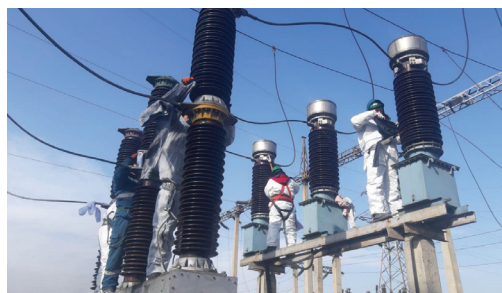
110/10 кВ-ын ПРП-110 дэд станцын моноглолын хөндийрүүлгийн бохирдолт цэвэрлэж байгаа нь
