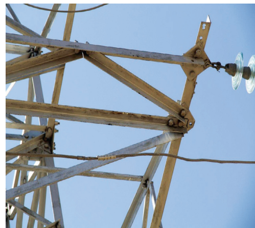
110 кВ-ын Айраг-Сайншанд ЦДАШ-д 240-246 шувууны үүртэй, А №204 3-р фазын траверсны үзүүр ниргэлтийн мөртэй
