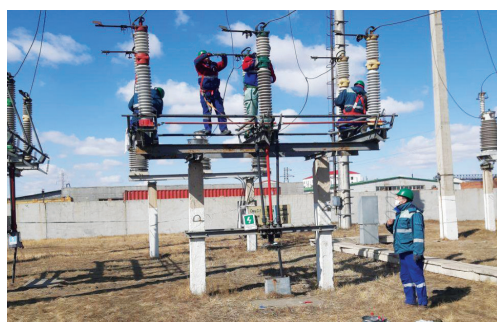
110/35/10 кВ-ын Цэвэрлэх дэд станцын 110 кВ-ын СС-2-ын урсгал засварын ажил
