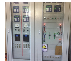
Бугант дэд станцын Т-1, 2, 35 кВ-ын Орлолт-1, 2-ын панель
