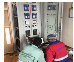
Бугант дэд станцын Т-1, 2, 35 кВ-ын Орлолт-1, 2-ын панель
