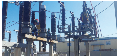
110/10/10 кВ-ын Баруун дэд станцын дотоод хэрэгцээний трансформатор-1-ийн их засварын ажил
