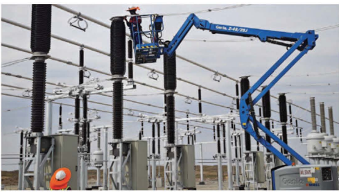
ЦДАШ угсралт, суурилуулалтын үеийн фото зураг:
