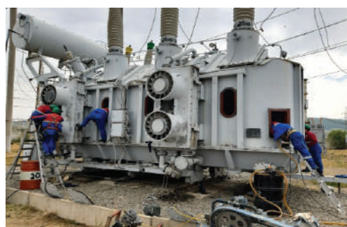
Улаанбаатар дэд станцын АТ-1-д их засварын ажил гүйцэтгэж байгаа нь
