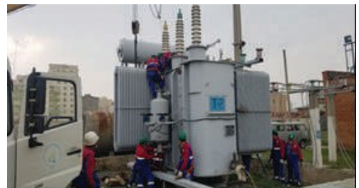
110/10/10 кВ-ын Гео дэд станцын Т-2 тр-рын радиаторын жийрэг резин сольж байгаа нь
