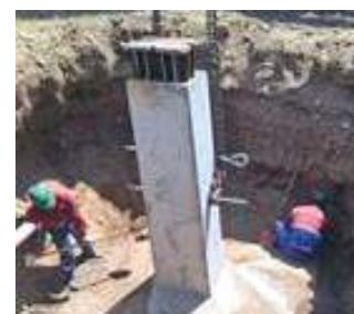
У110-2 маркийн тулгуурын хөл суурилуулж байгаа
